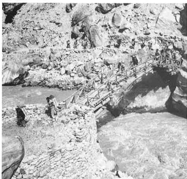
コンダス河下流を渡りフーシェ村へ
